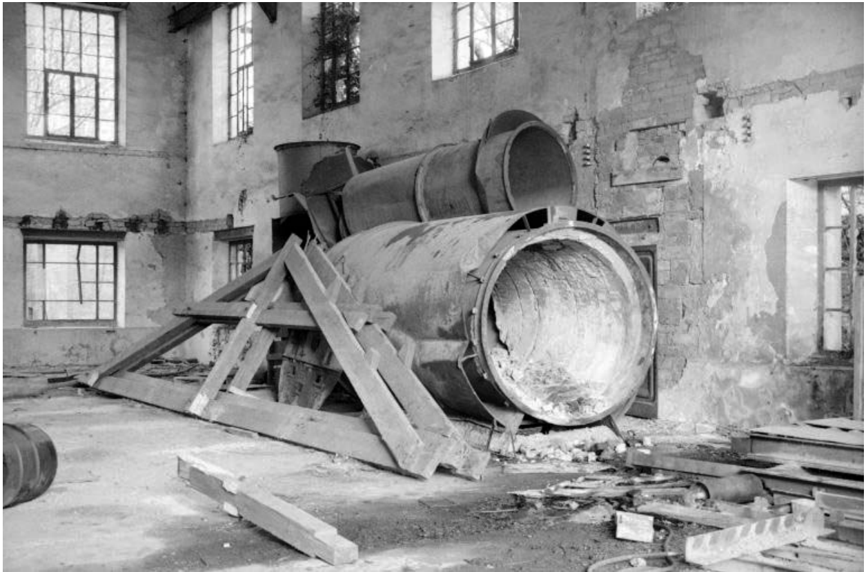
Forge Neuve. Centrale électrique : élément de fourneau (?) dans la salle des machines (H).
