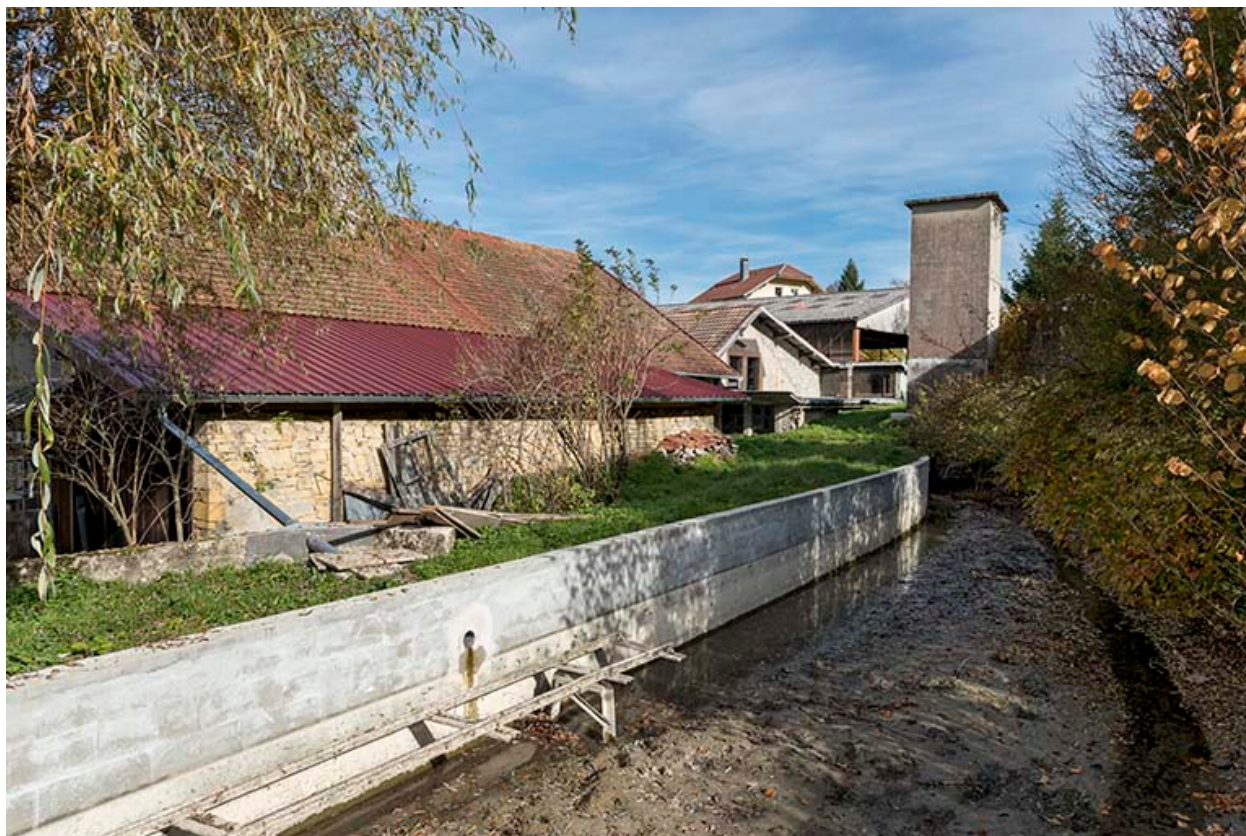
Bâtiment ancien : façade postérieure et canal d'amenée.
