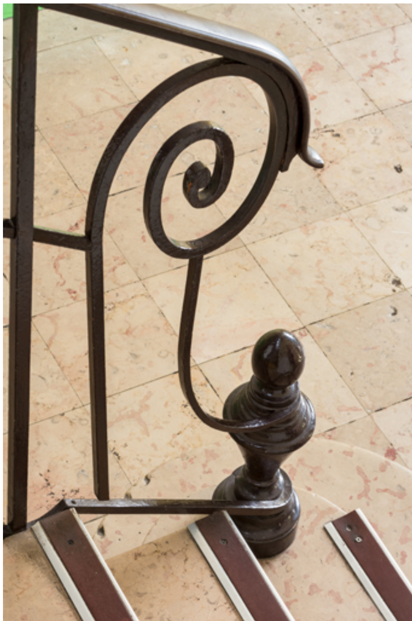
Détail du garde-corps de l'escalier.
