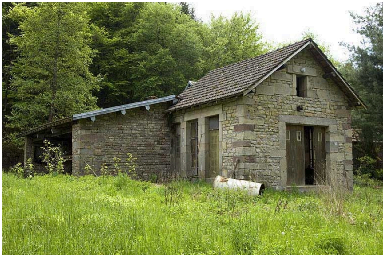
Bâtiment d'eau (local des turbines).
