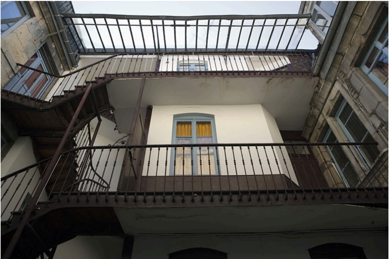
Détail de l'escalier à cage ouverte sur cour.
