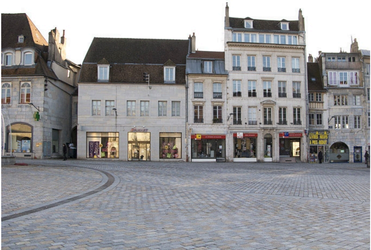
Vue d'ensemble éloignée des façades des logis secondaires de l'ancien hôtel, depuis la place de la Révolution.
