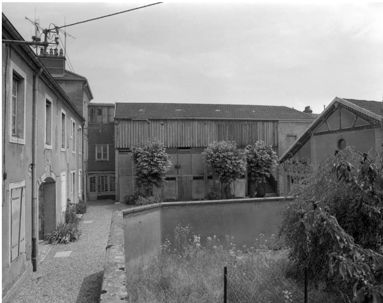
Entrepôt commercial à gauche de la cour.
