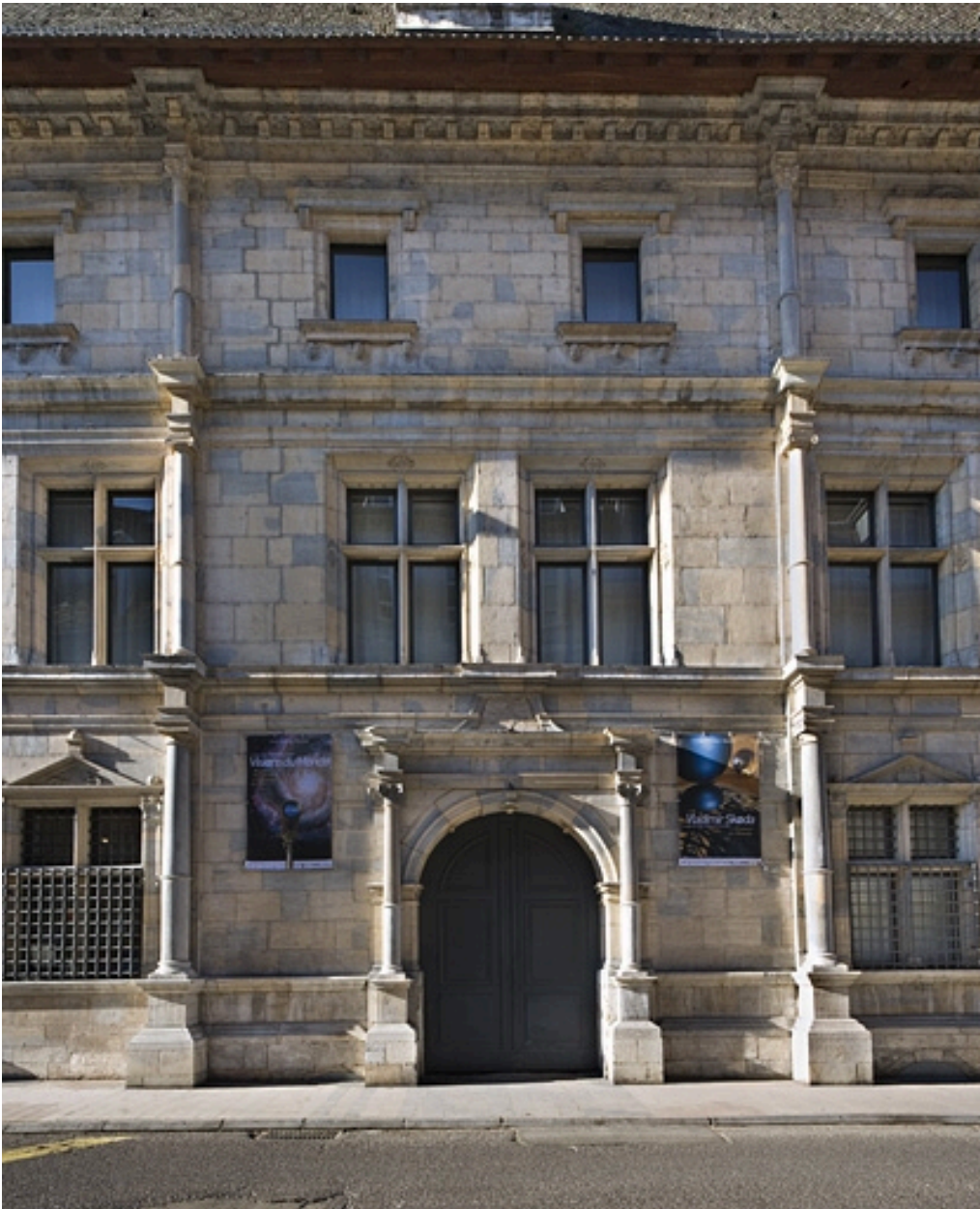
Façade principale : détail de la travée centrale.
