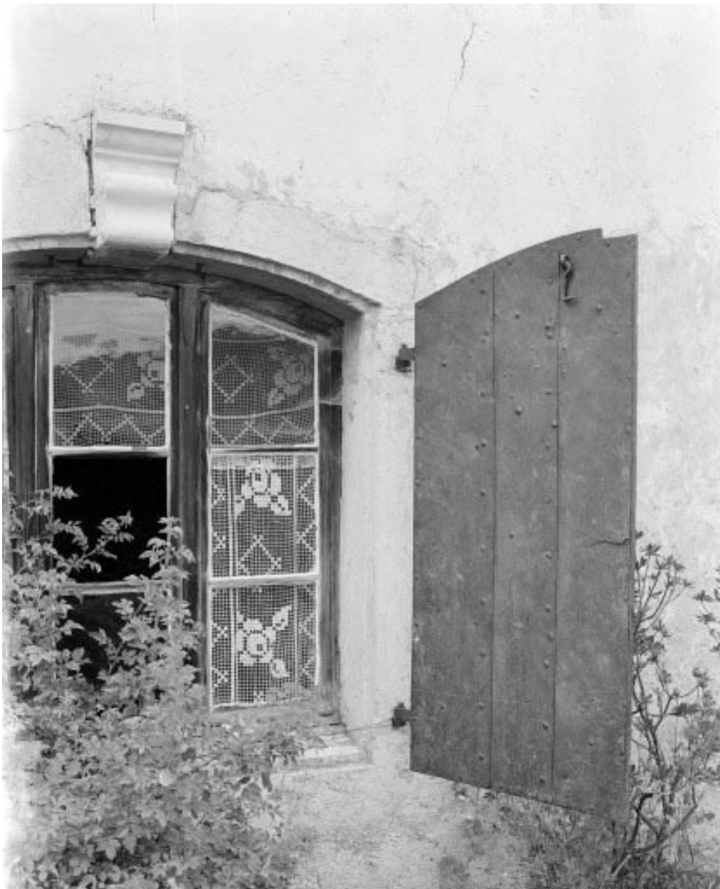
Fenêtre du "carré" : volet ouvert.
