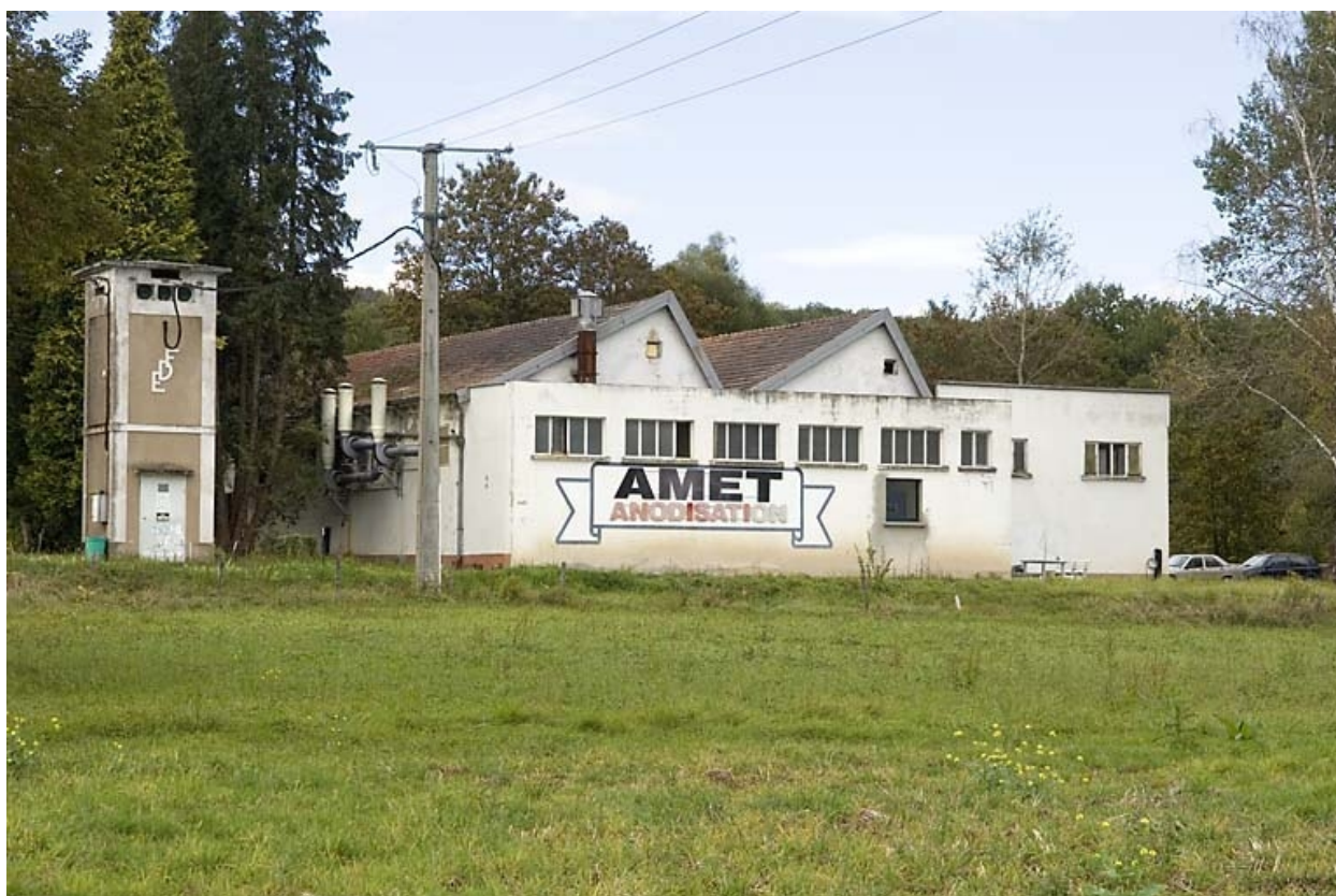
Vue depuis le sud.
