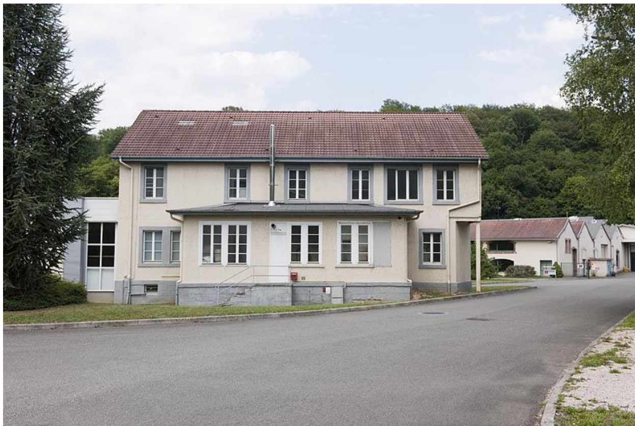
Ancien bâtiment des bureaux. Façade sud.
