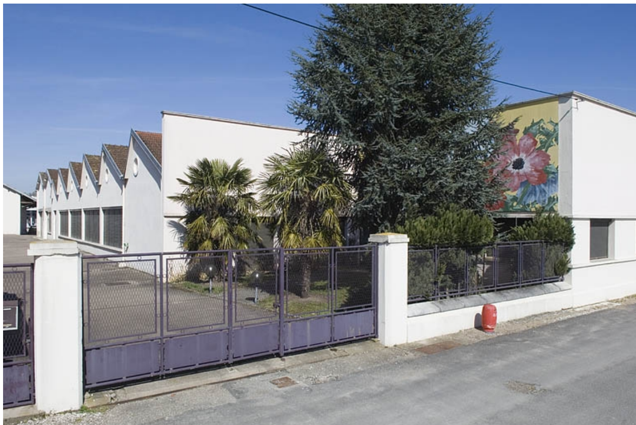
Vue de l'atelier depuis l'ancienne entrée.
