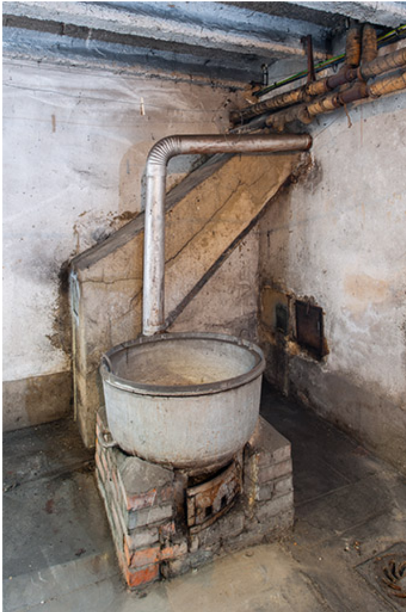
Bâtiment de l'administration, sous-sol : chaudron à lessive.
