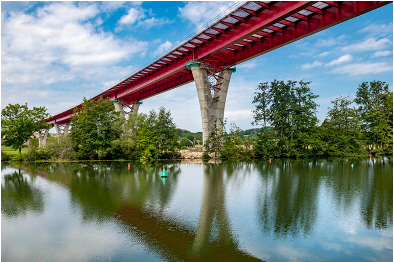
le viaduc en construction (déviation de Port-sur-Saône).
