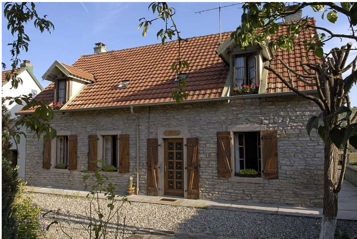
Façade postérieure d'un logement ouvrier.
