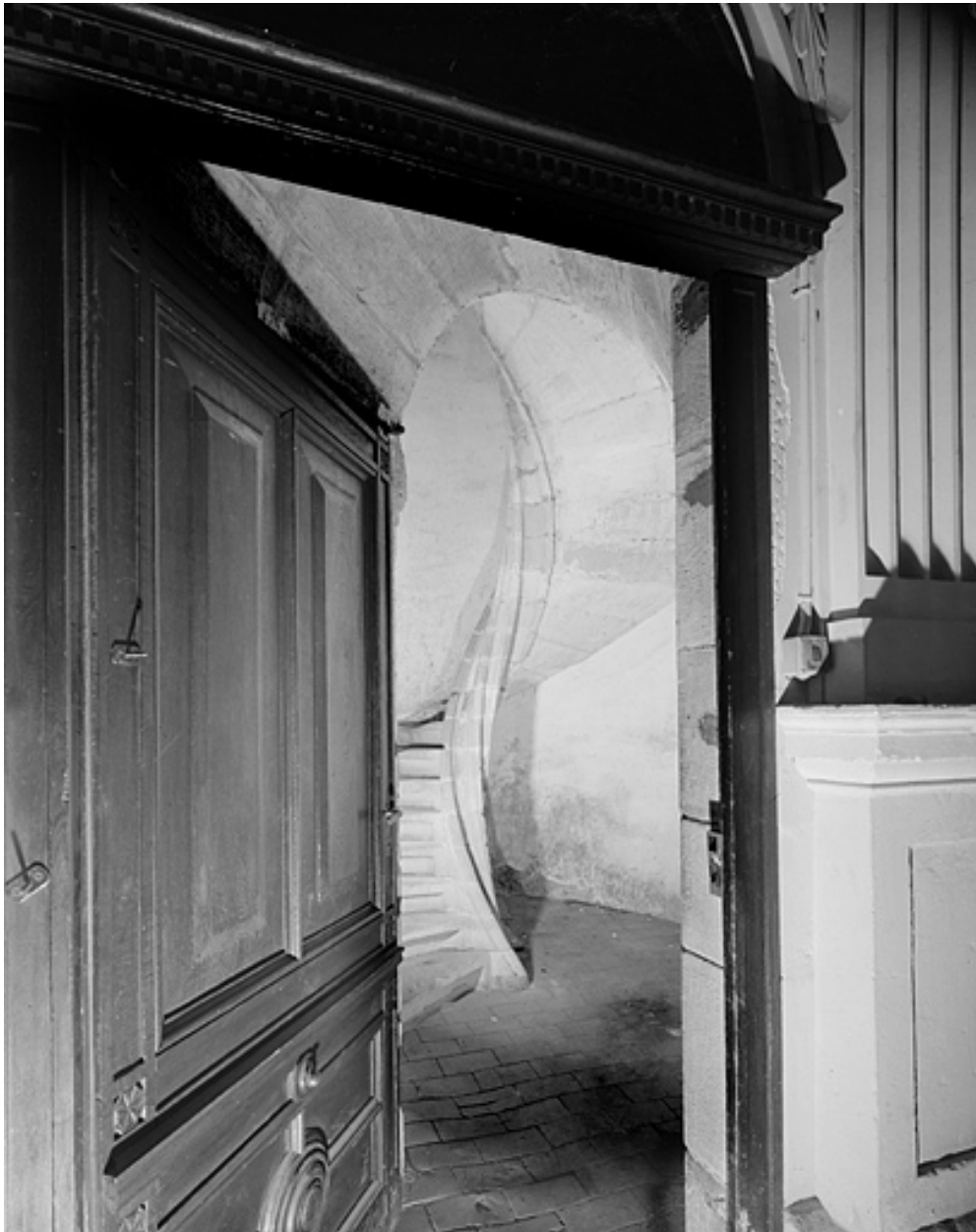
Escalier de la tour nord.
