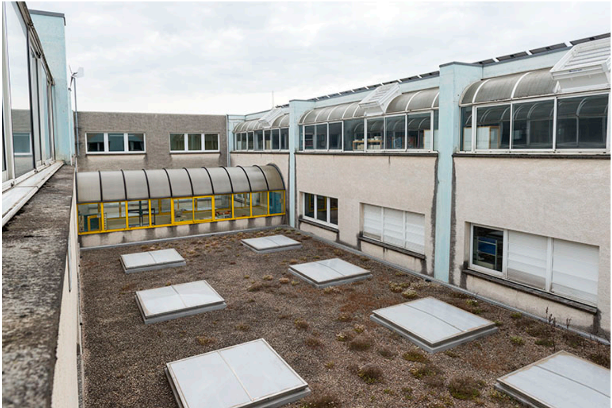
Façades intérieures et toit terrasse du bâtiment de l'angle sud-est (atelier, administration).
