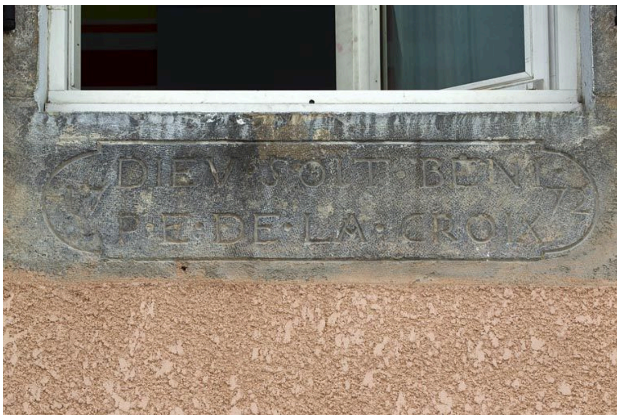
Linteau remployé comme appui de fenêtre.
