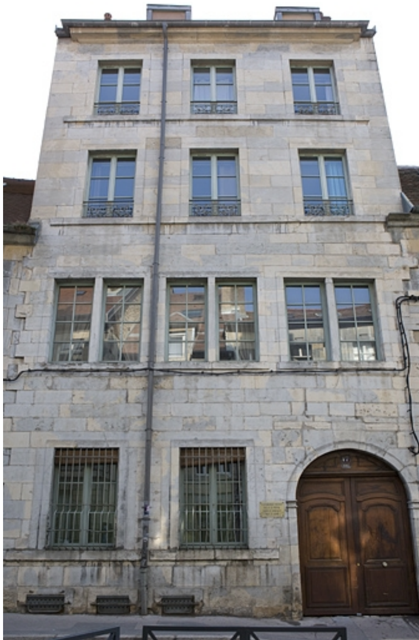
Façade sur rue : de face.
