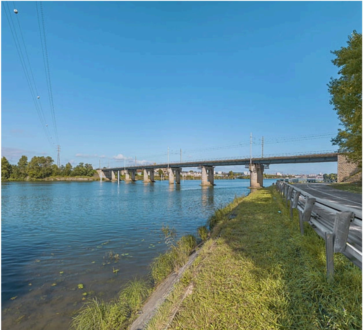
Le pont vu d'aval, rive gauche.
