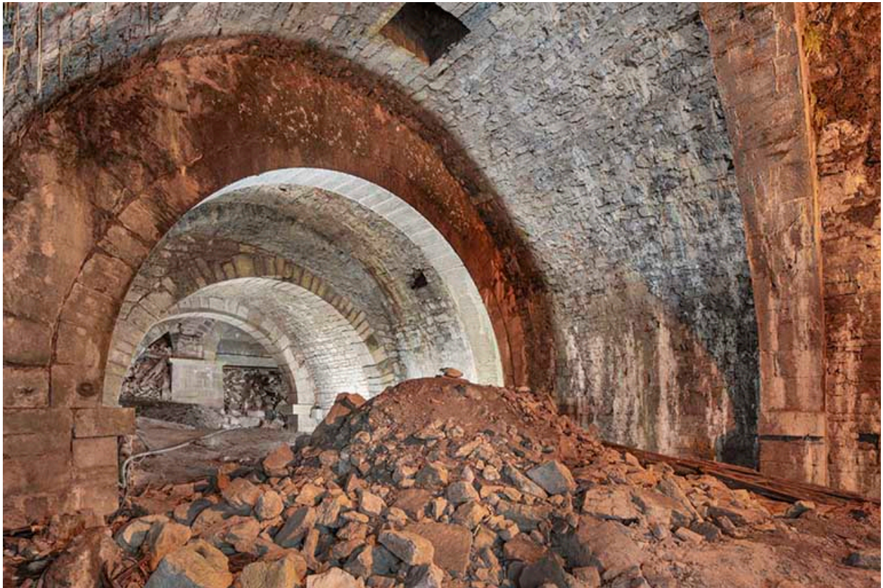
Travée est du puits d'Aval. Vue depuis le nord.
