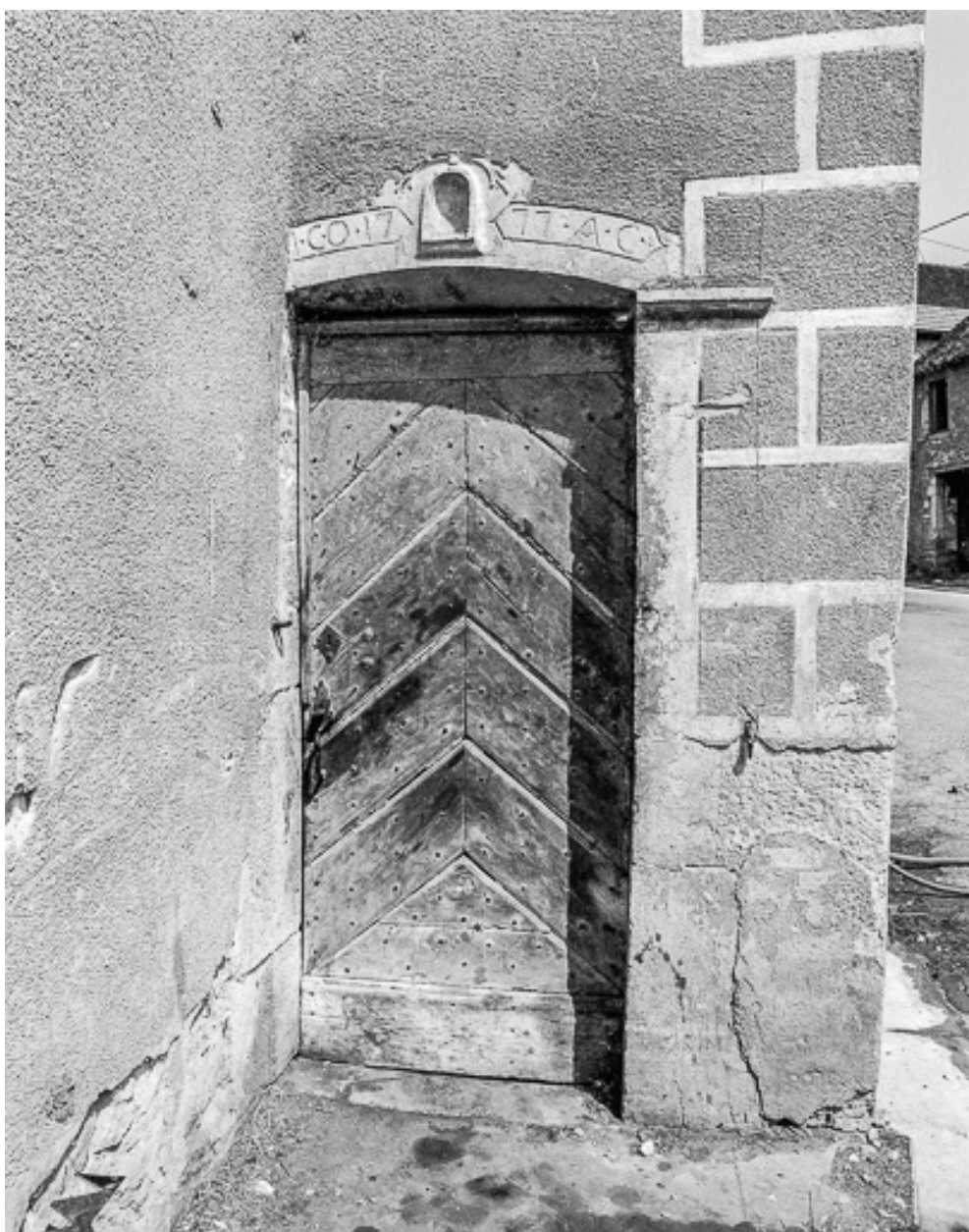
Maison située rue d'Amont à Chenevrey : détail de la porte de la façade antérieure.
