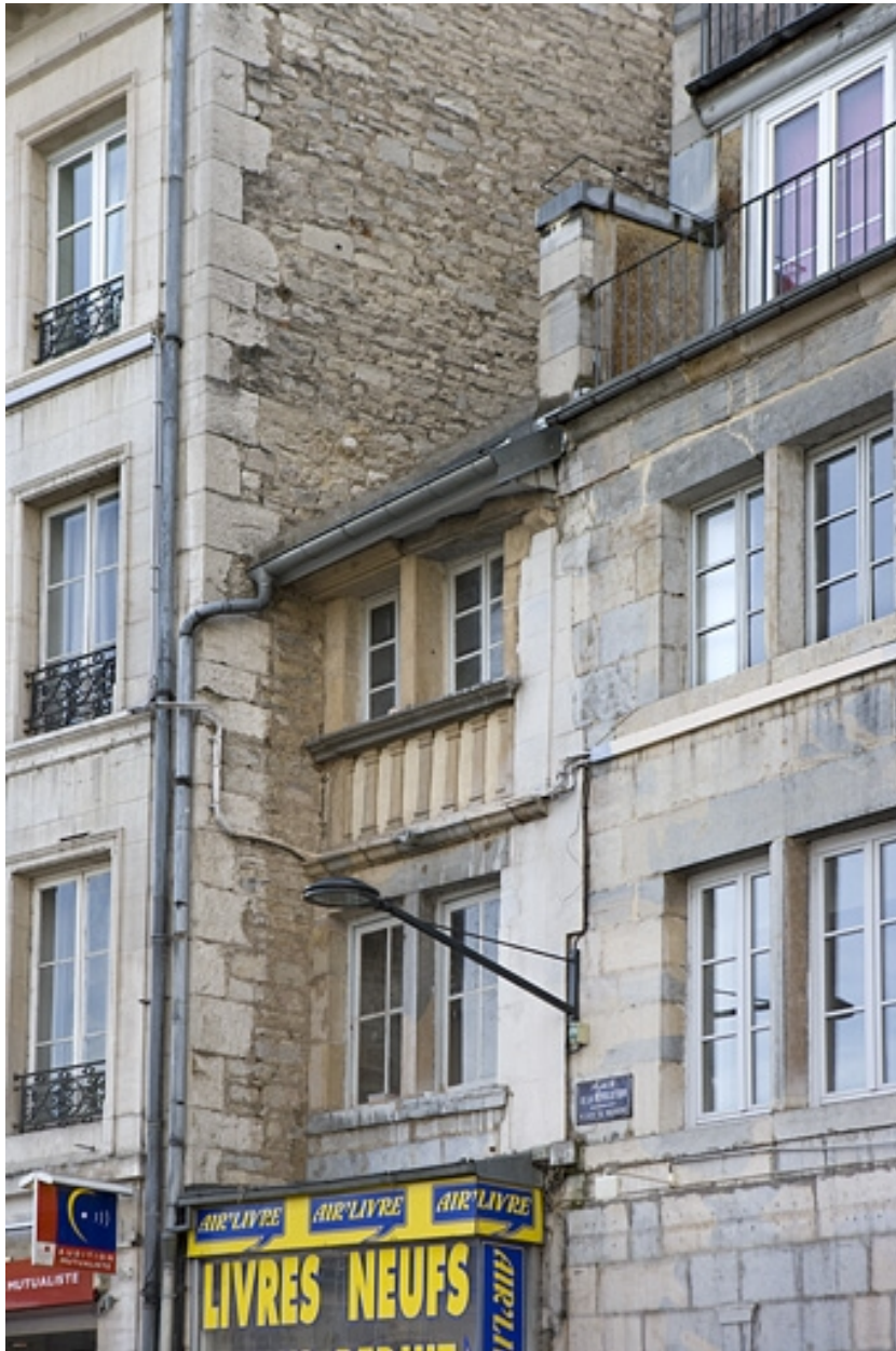
Vue d'ensemble des parties supérieures de l'entrée cochère.
