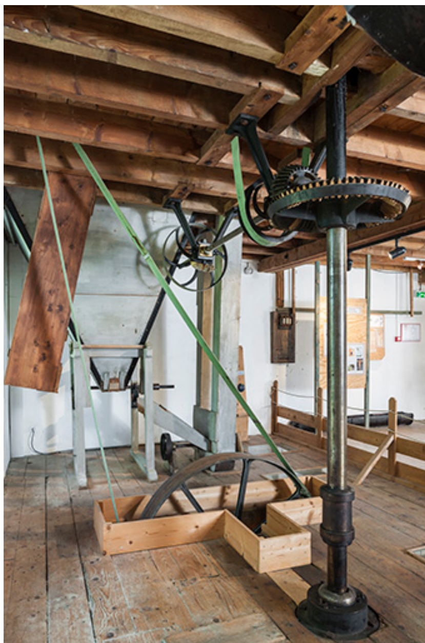
Deuxième étage. Système de transmission.
