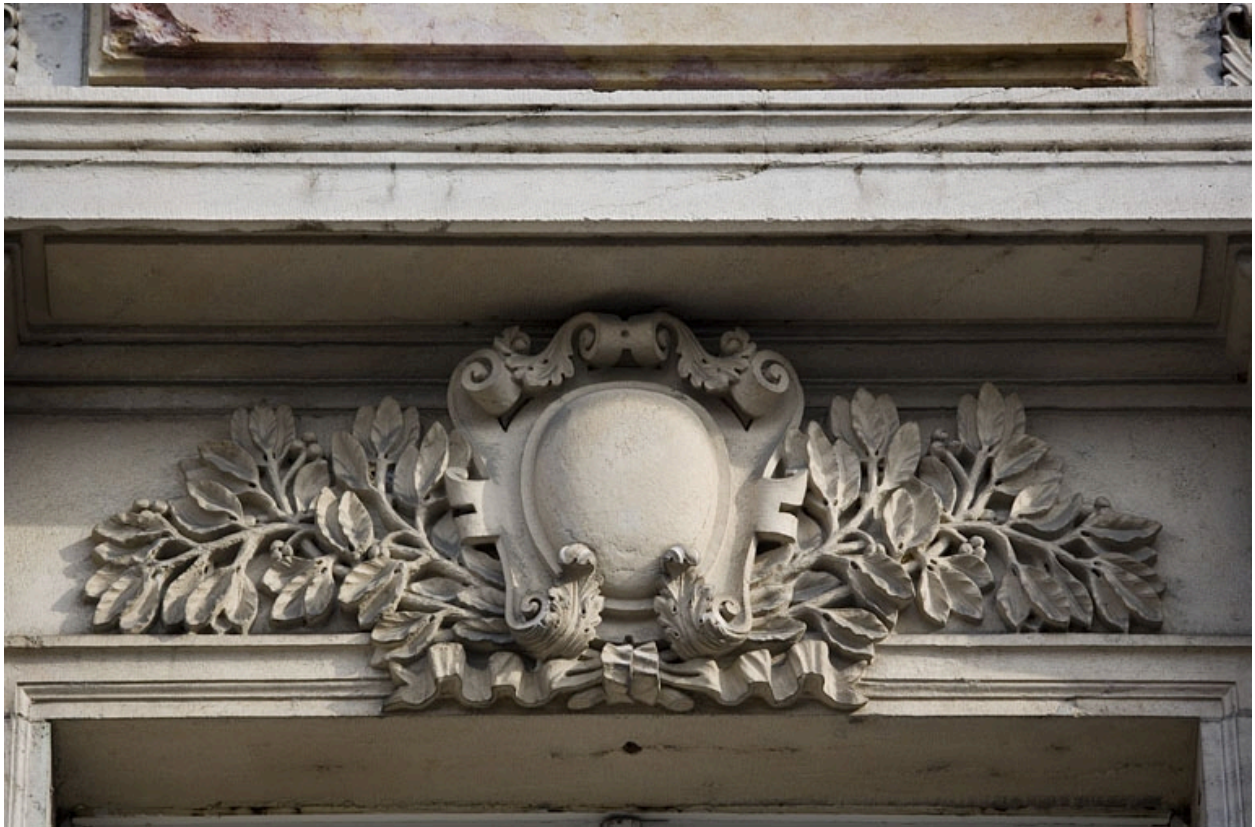
Détail du décor sculpté sur l'une des fenêtres du premier étage.
