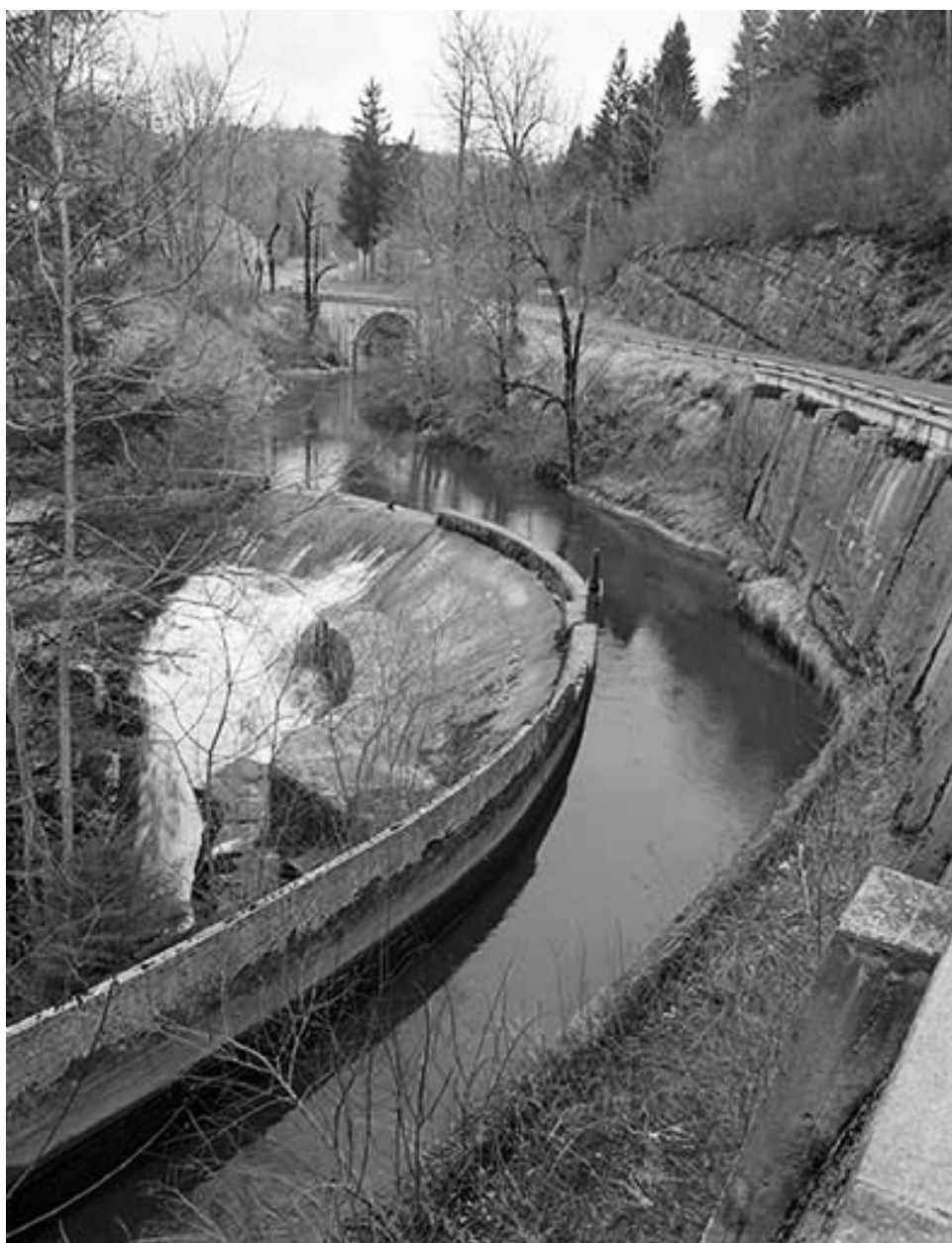
Canal d'amenée de la centrale.
