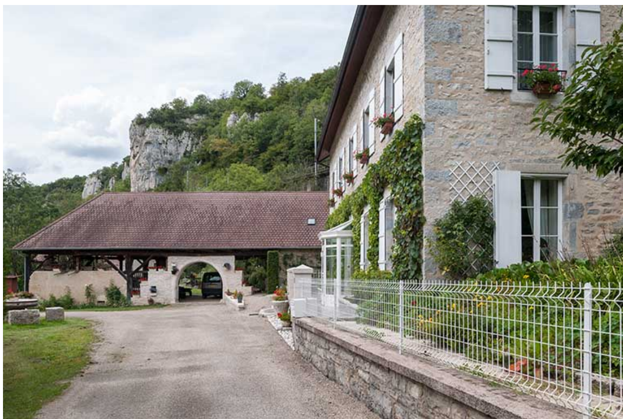
Vue depuis l'entrée du site.
