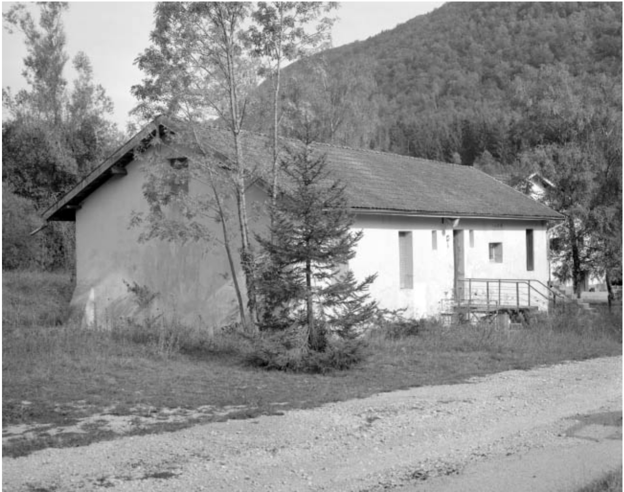
Logement d'ouvriers, vu de trois quarts gauche.
