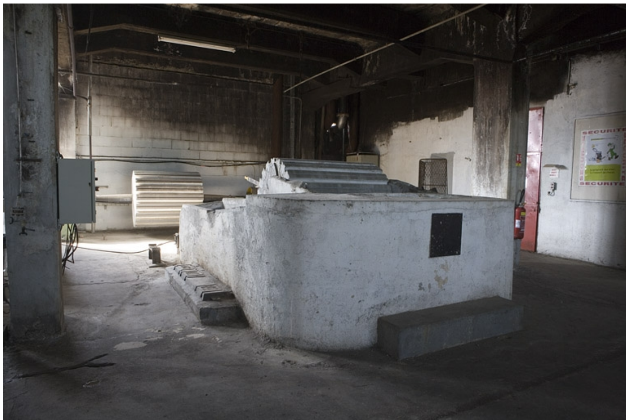
Pile raffineuse. Vue arrière.
