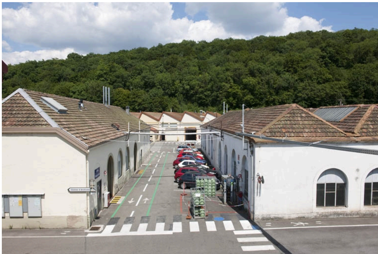
Magasin industriel et atelier de maintenance.
