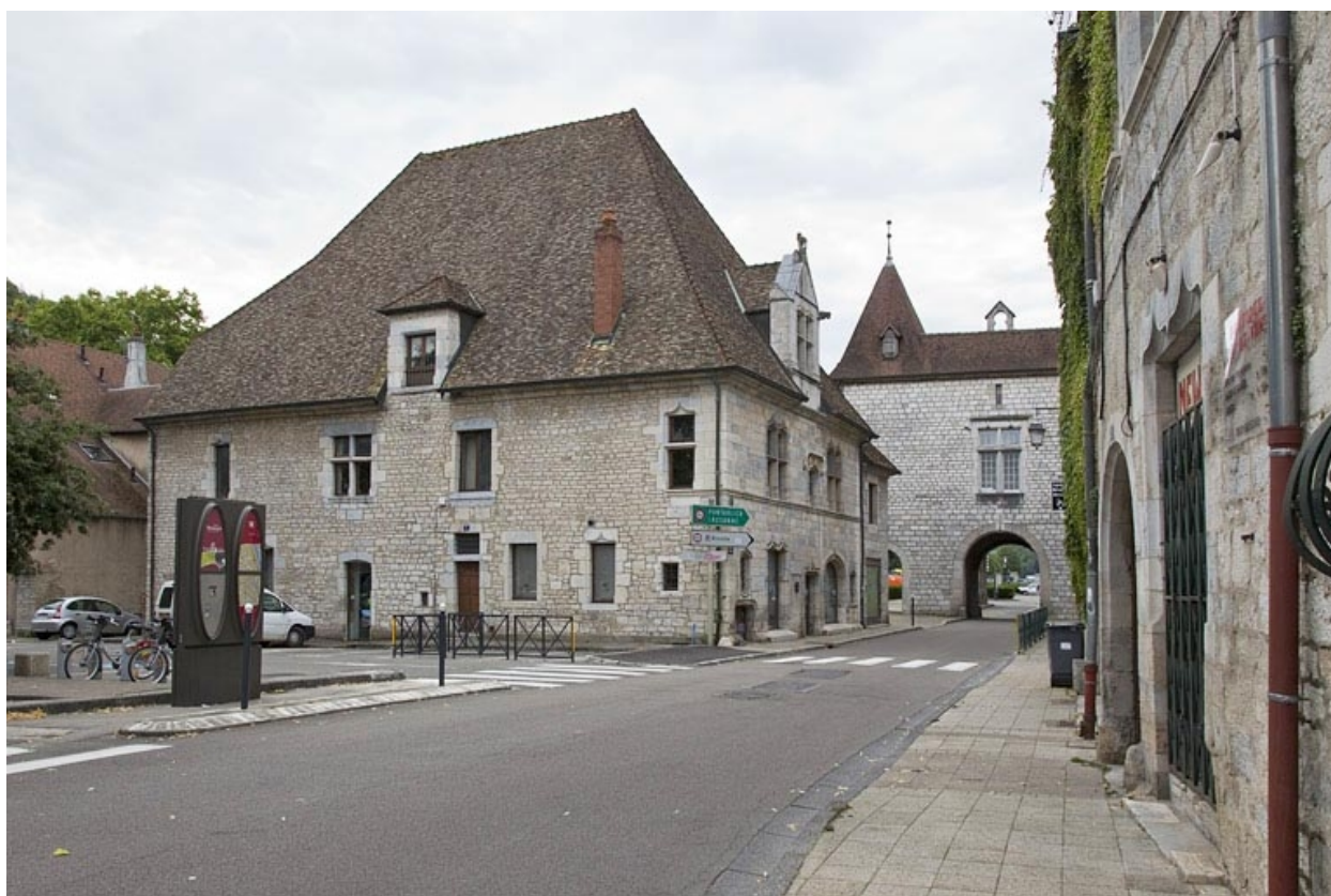
Vue d'ensemble éloignée, de trois quarts gauche.
