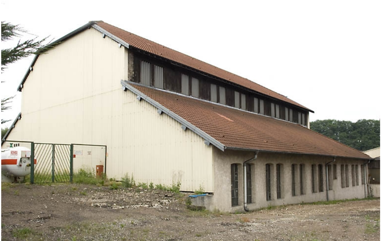
Atelier de fonderie depuis le nord-est.
