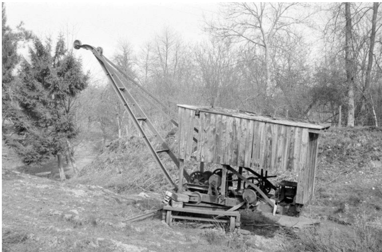
Grue sur voie étroite dans l'ancienne carrière.
