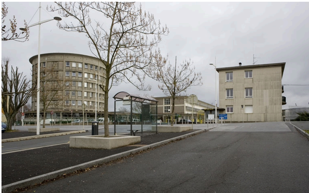
Vue d'ensemble côté entrée.
