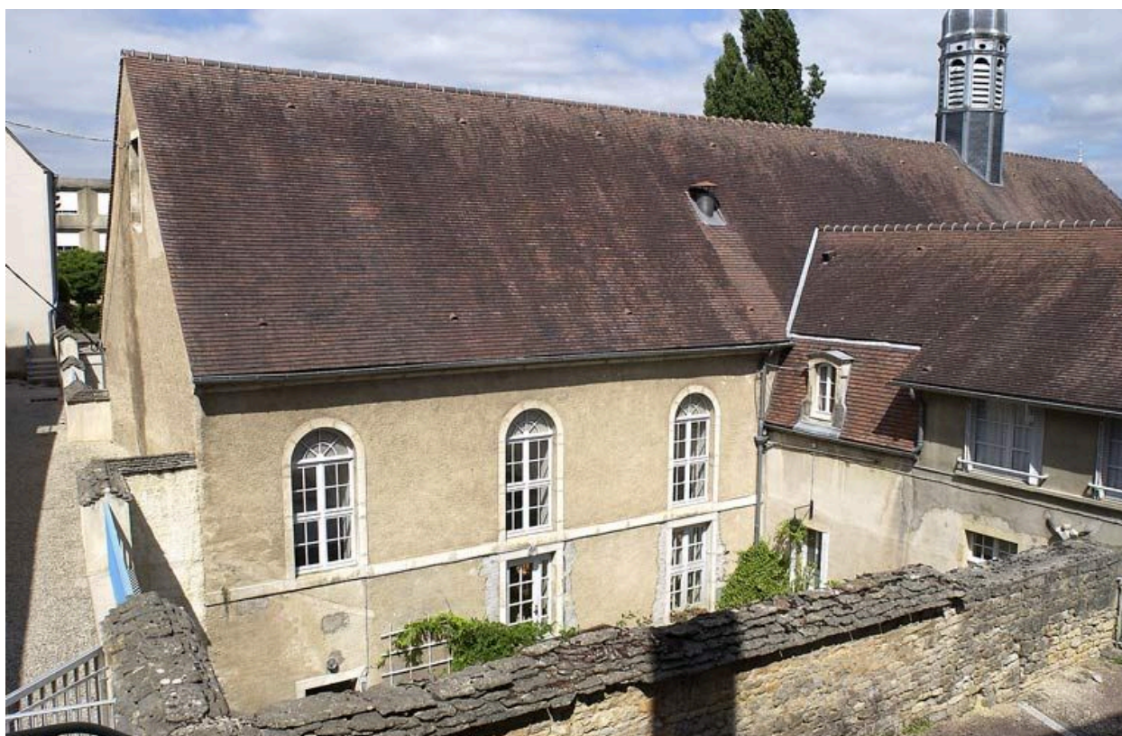
Façade antérieure de l'extension de la salle des hommes.
