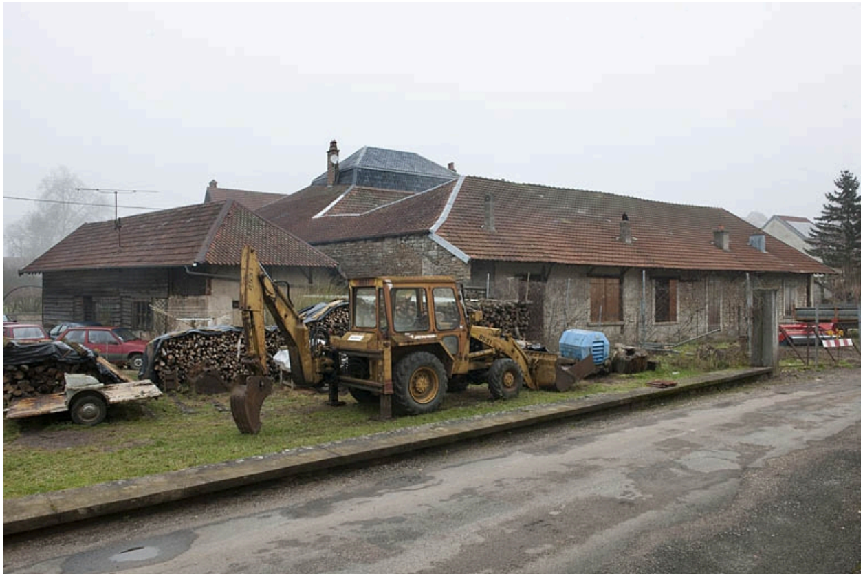
Vue générale du sud-ouest (façades postérieure et latérale droite).
