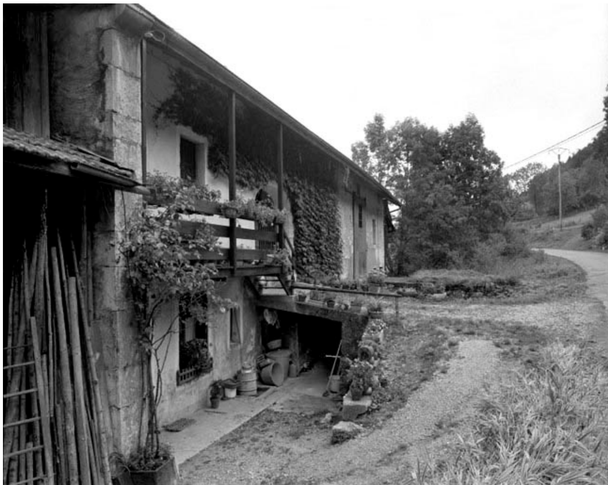
Larrivoire, ferme située au lieu-dit Samiat : pont de grange.
