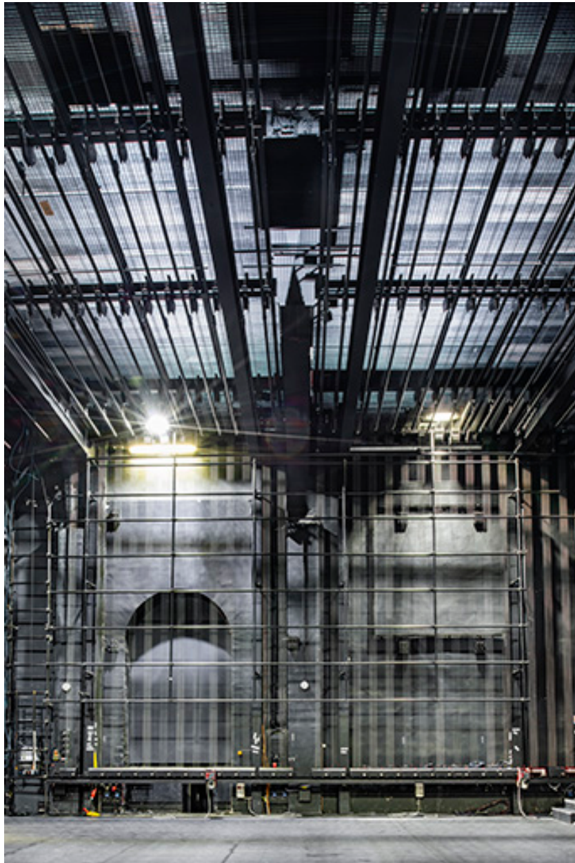
Salle, mur latéral nord-ouest, vue de face.
