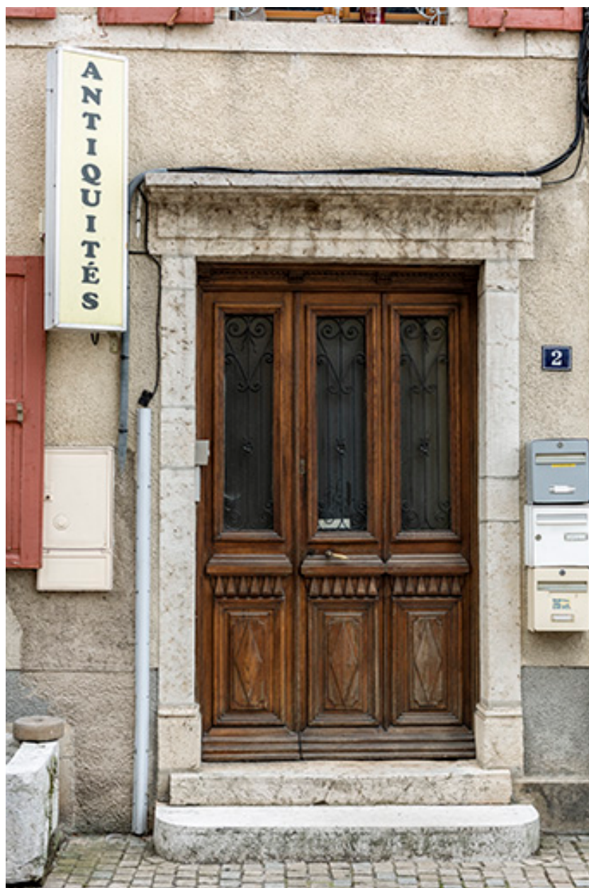
Immeuble 2 rue Jacques Courtois : entrée.
