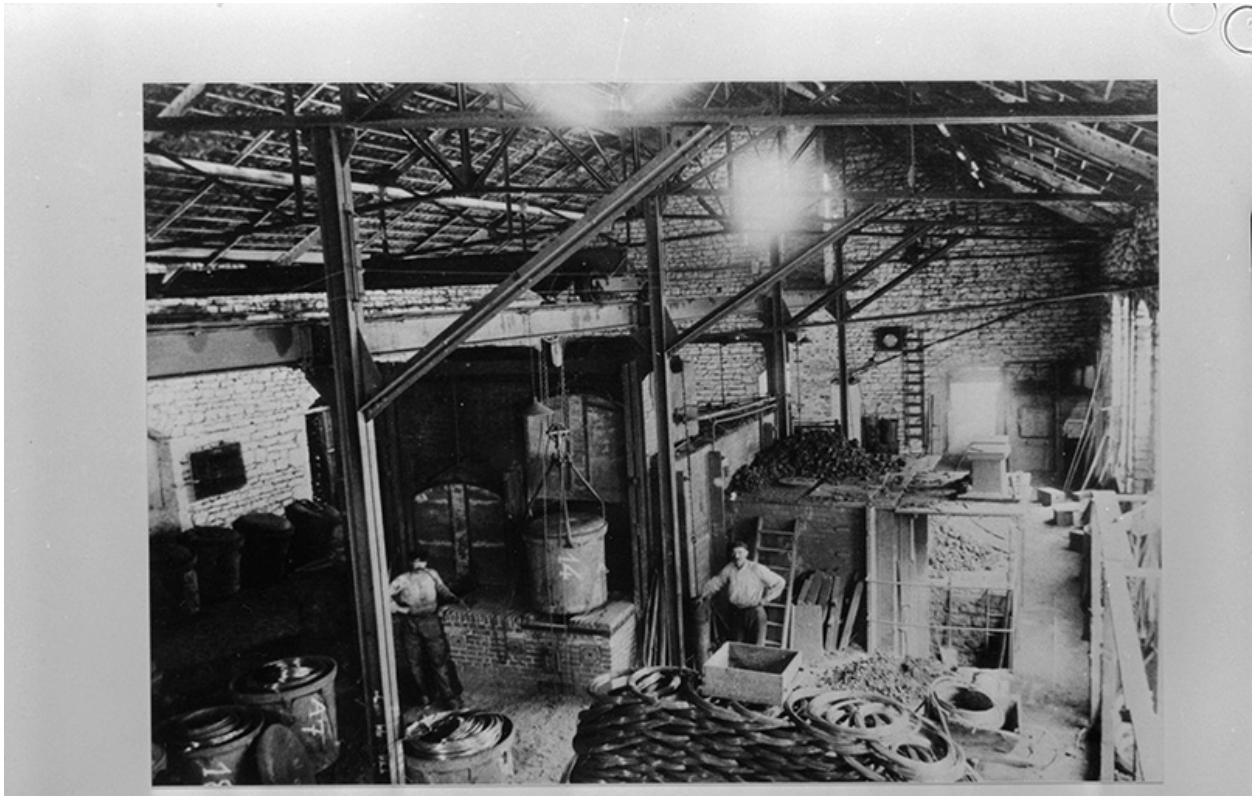
Atelier du four à recuire, fotogr., s.n., s.d. [vers 1890-1900].
