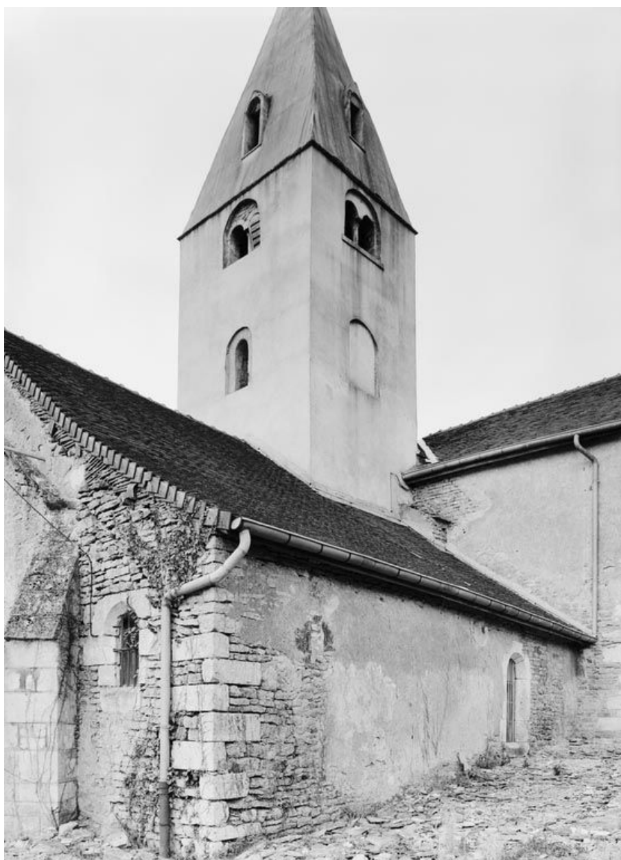
Elévation gauche du choeur et clocher.
