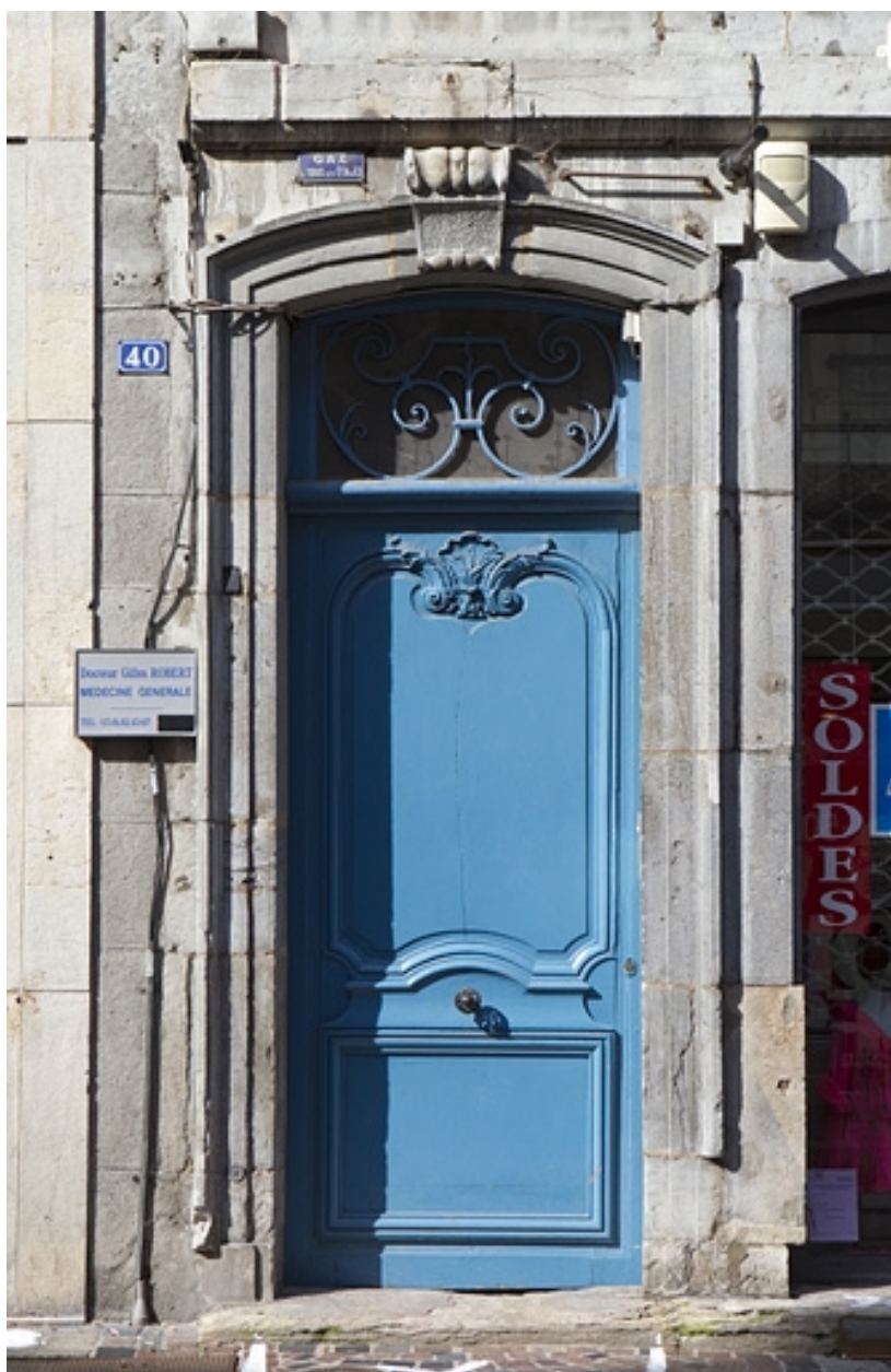
Détail de la porte du couloir d'entrée.
