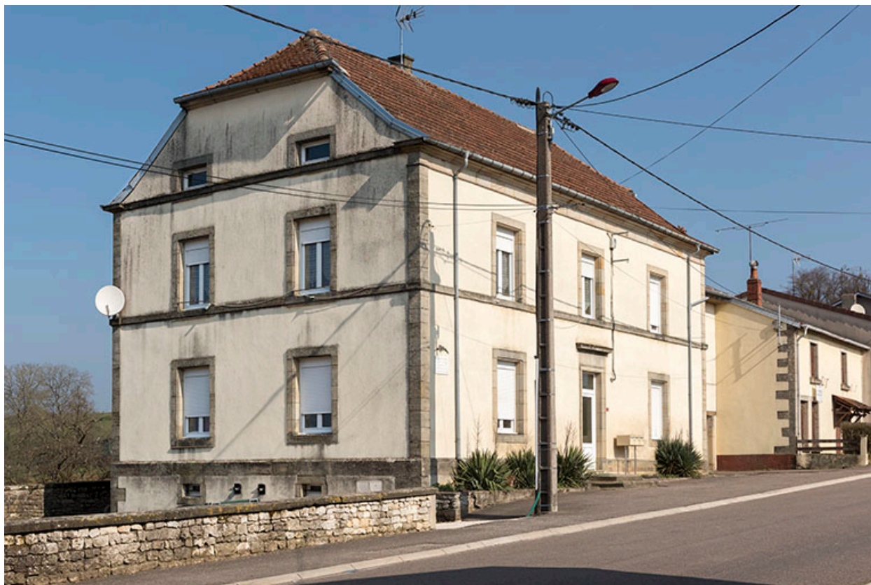
Maison d'école. Vue de trois-quart sud-ouest.
