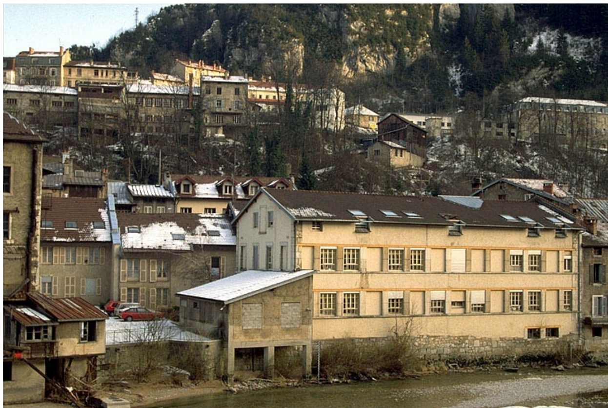
Façade postérieure de l'usine.
