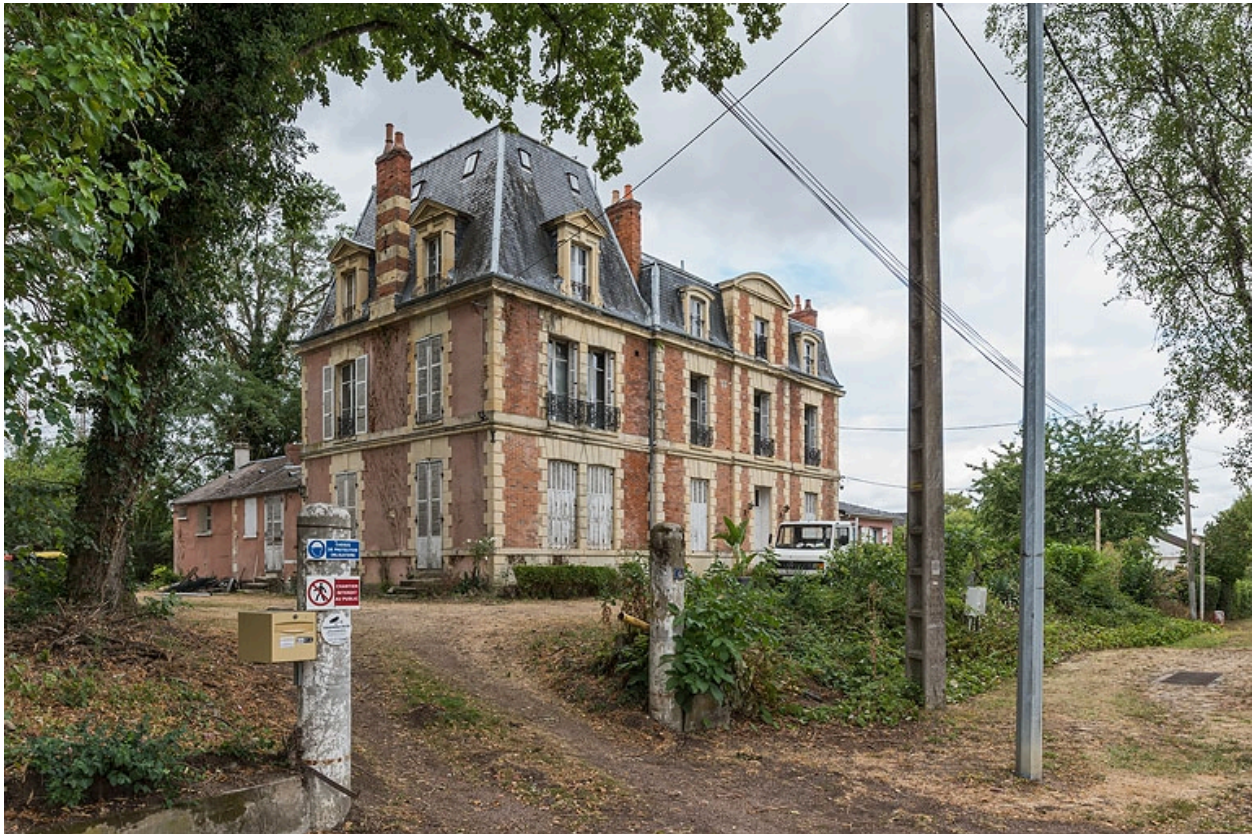
Vue d'ensemble depuis l'accès sur l'avenue de Paris.
