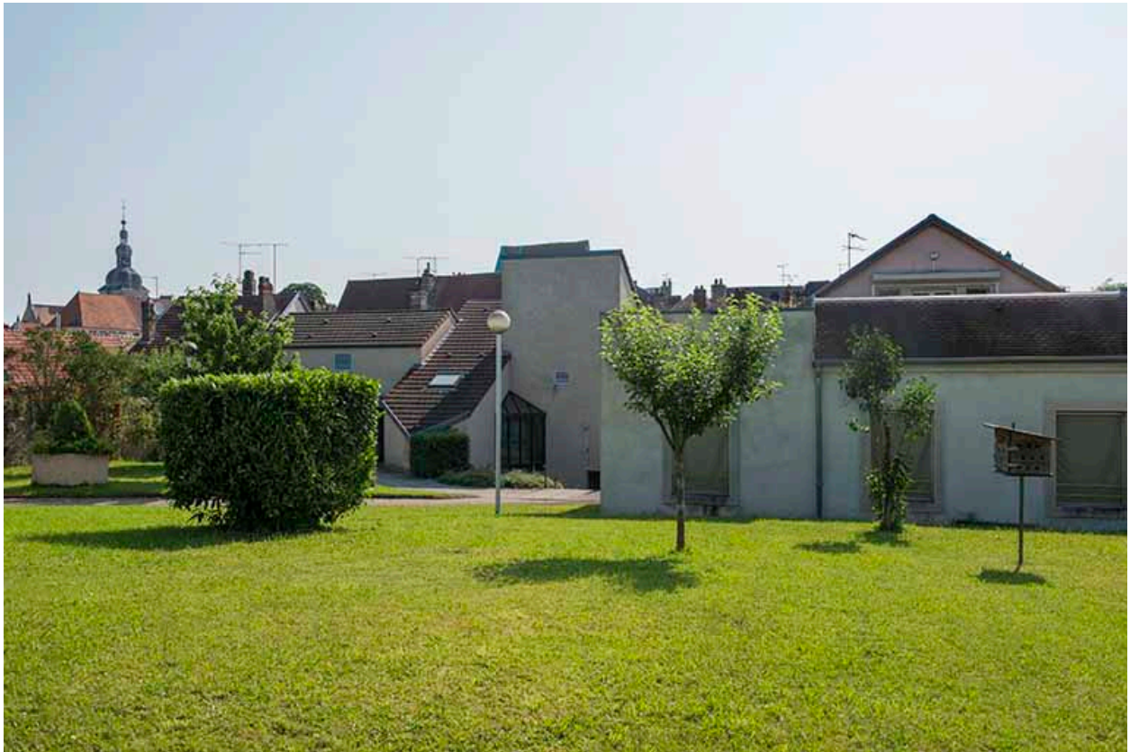
Vue d'ensemble des façades postérieures nord-ouest de la cantine.
