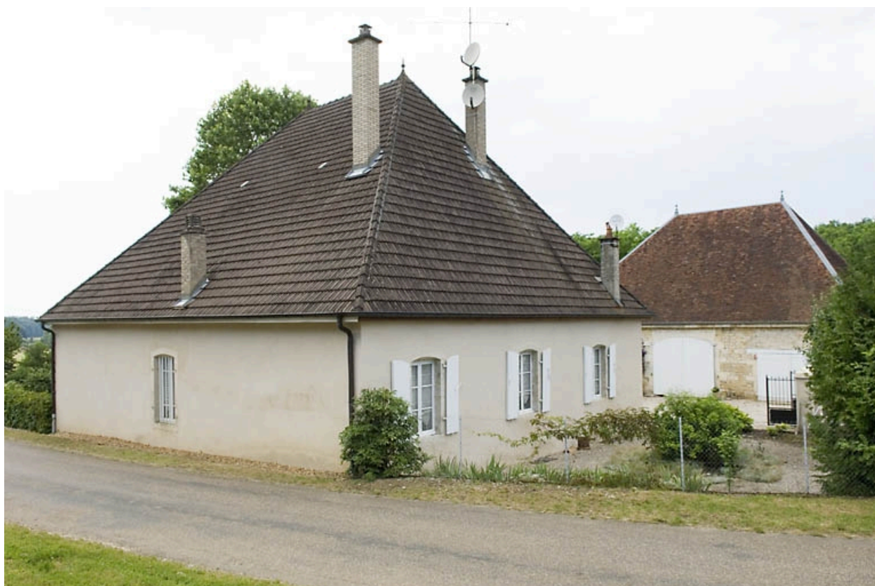
Logement patronal et haut fourneau.
