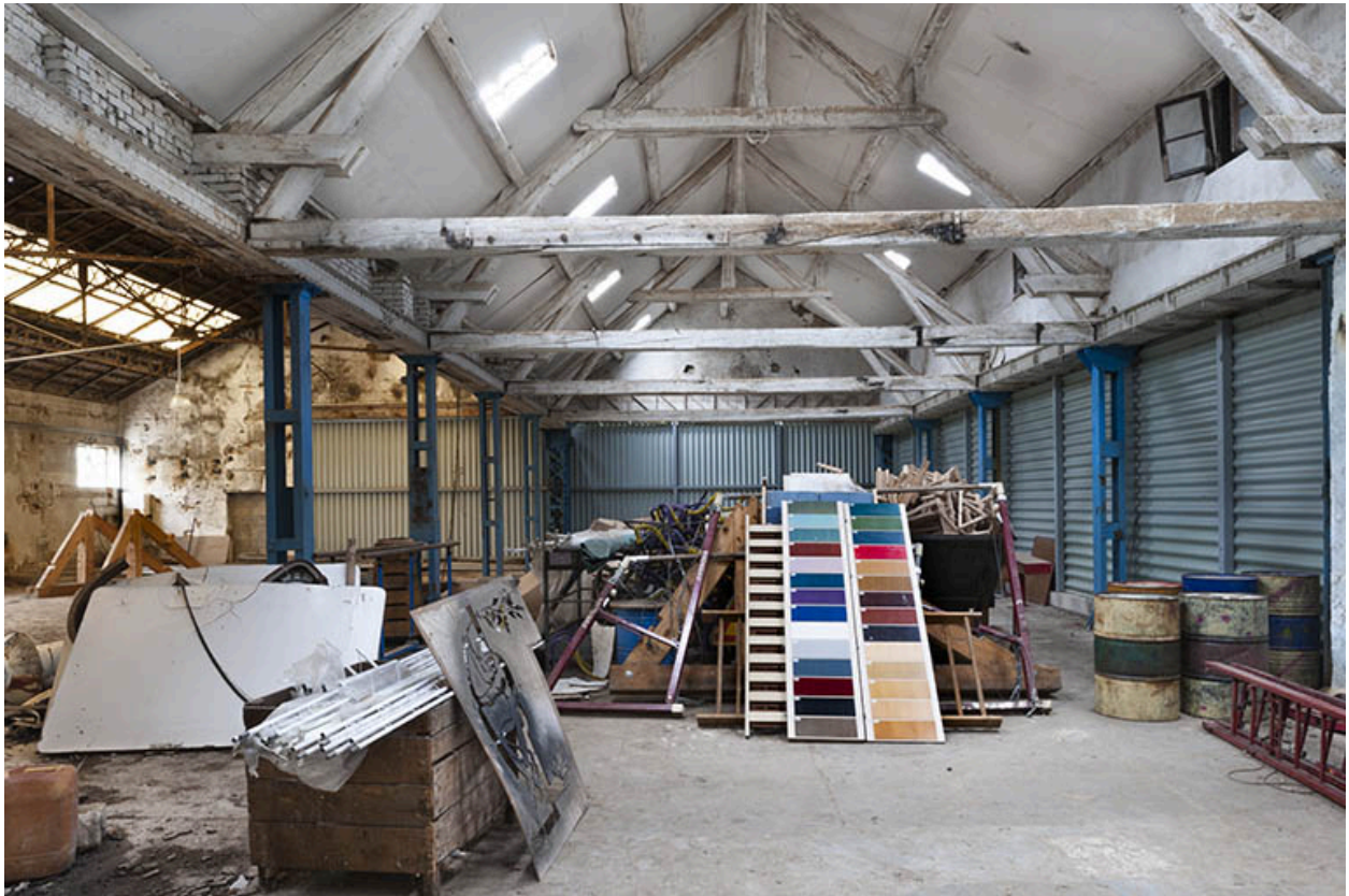
Atelier d'usinage. Vue intérieure.
