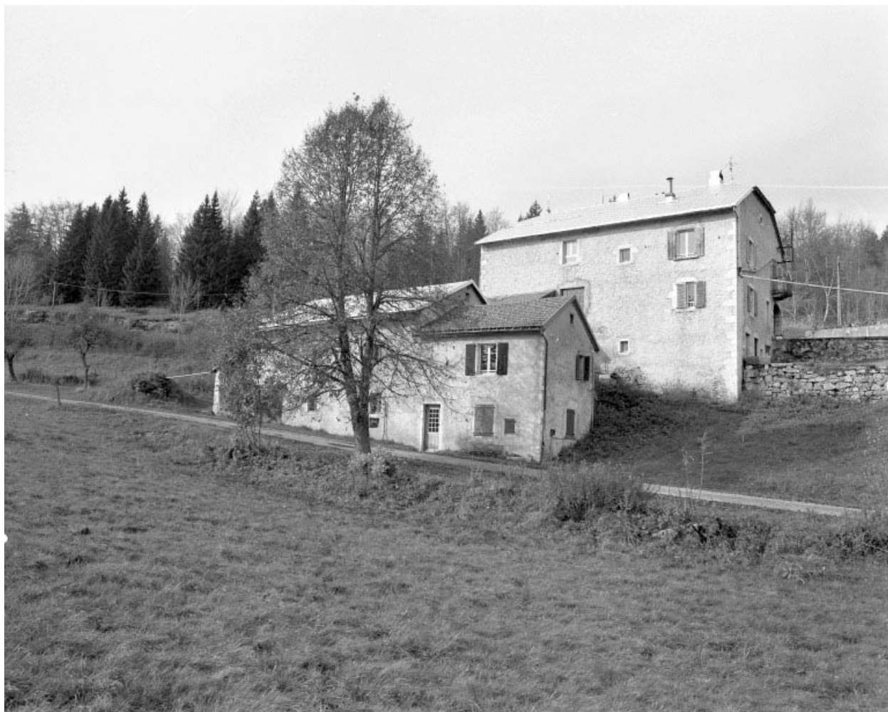
Façade postérieure, vue générale.
