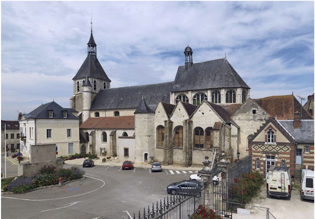
Eglise de Briennon-sur-Armançon, vue d'ensemble.
